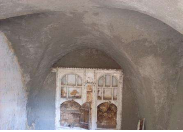
البيت الطيني المصلب بعد ترميمه بالإسمنت
